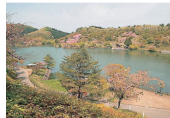
八塩ダム貯水池
